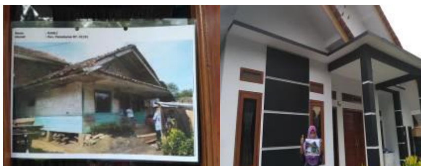
Gambar 5. Rumah Warga Sebelum dan Sesudah Renovasi
