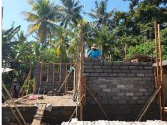
Gambar 6. Pembangunan Rumah Swadaya Kota Langsa
