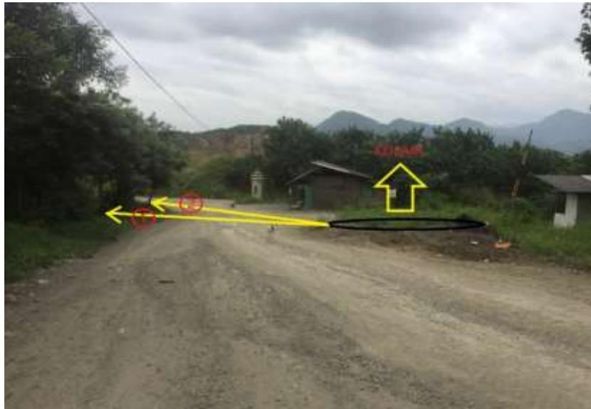
**Gambar 3.** Desain *Outlet* Gorong-Gorong (catatan: panah untuk *outlet* kedua sebenarnya masih menerus ke arah kiri. Gambar dibuat demikian agar tidak menimbulkan mispersepsi)
