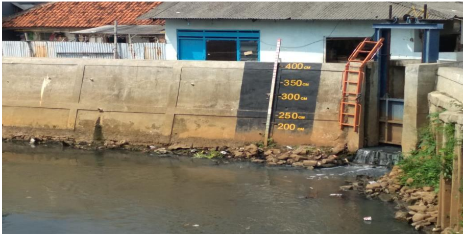
Gambar 8. Kali Sebelah Kiri Jalan Raya Bagian Batas Ketinggian Air
