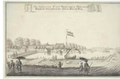
Pemandangan Gudang di Indramayu 1772-1775 Sumber: Koleksi Foto PNRI. No Inventaris BWNXXII. Jakarta: Perpustakaan Nasional RI.
